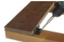
TENI Clip in der Hohlkehle ansetzen. Die Schraube bis zu einem Fugenbild von 6mm eindrehen
