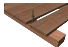
Nach erfolgtem Verschrauben Distanzbolzen entfernen – fertig!
